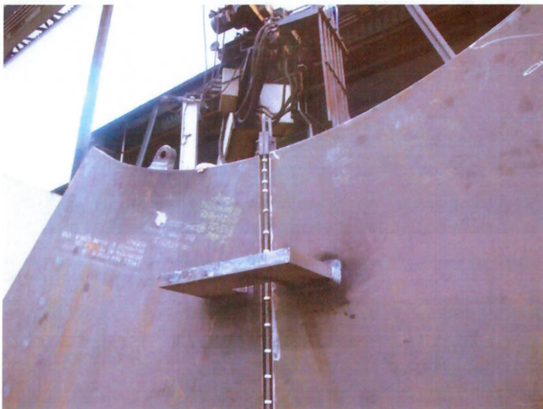
Figura 2.9 Exemplo de preparação de junta para soldagem por eletro escórias. (Figura gentilmente cedida pela empresa Voith Hydro – São Paulo).
